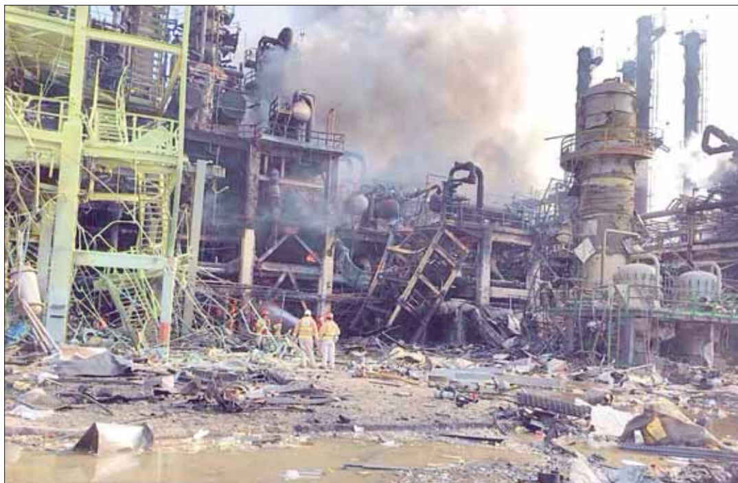
Imagen de la destrucción en la planta de Clorados III del complejo petroquímico de Pajaritos, Veracruz. El director general de Pemex, José Antonio González Anaya, dijo que se contratarán peritos externos para determinar la causa del estallido ■ Foto proporcionada por trabajadores de Pemex
