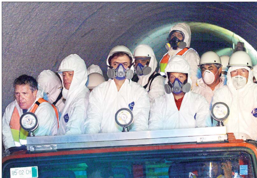
Marcelo Ebrard, jefe de Gobierno del Distrito Federal, acompañado por colaboradores y un equipo del Instituto de Ingeniería de la UNAM, puso en marcha la segunda etapa del programa de rehabilitación del Túnel Emisor Central del Sistema de Drenaje Profundo. Aseguró que con la inversión de 576 millones de pesos en la obra, la ciudad está segura para la temporada de lluvias ■ Foto José Carlo González
