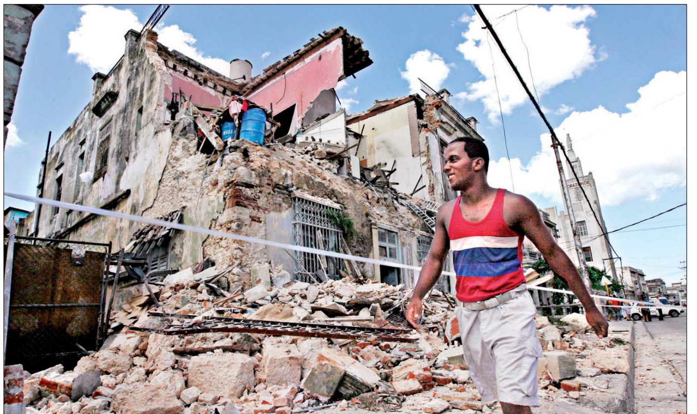
Los huracanes Ike y Gustav dañaron 444 mil viviendas en Cuba, dice el más reciente reporte oficial. Destrucción en La Habana ■ Foto Reuters
