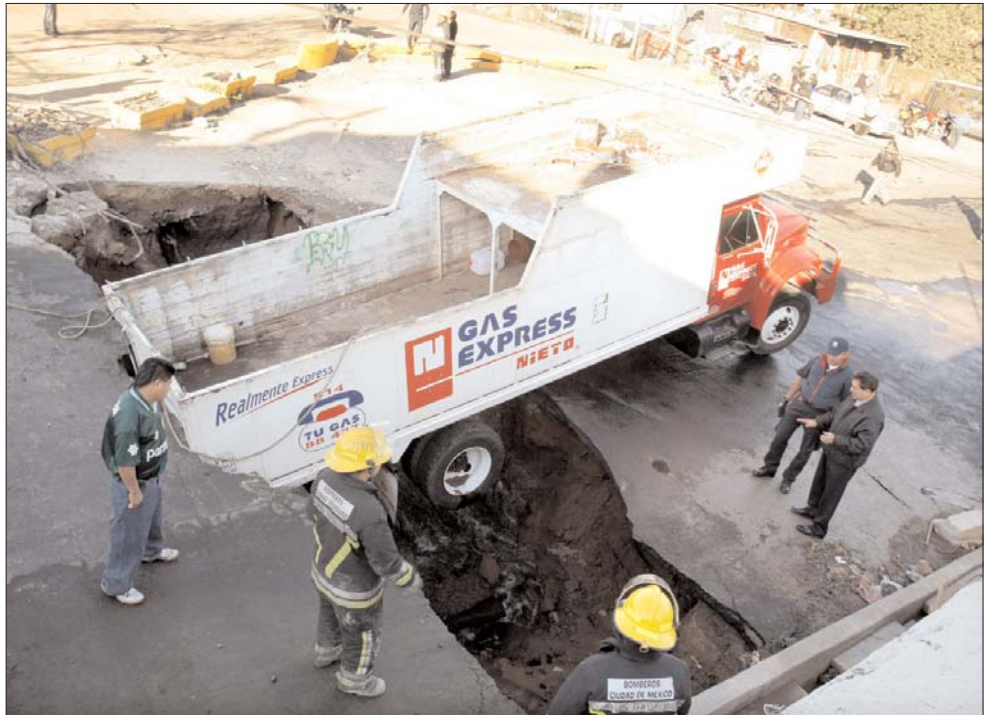
Una fuga en la red de agua potable provocó el reblandecimiento del suelo y un socavón de 11 metros de longitud y tres de profundidad, por el cual cayó un camión con tanques de gas. El incidente también causó daños a una vivienda de la colonia Ejército de Oriente. Autoridades acordonaron la zona y rescataron el vehículo con su carga para evitar el riesgo de explosión. “La situación está bajo control”, aseguró el secretario de Protección Civil, Miguel Moreno Brizuela, pese a las quejas de vecinos ■ Foto Alfredo Domínguez
