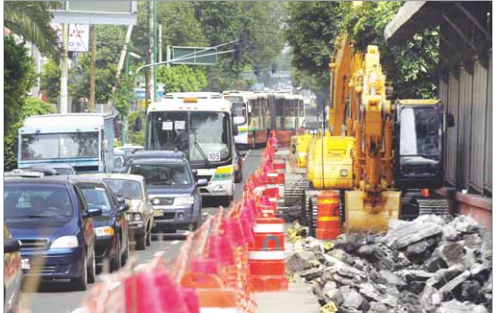
Las obras para cambiar el asfalto por concreto hidráulico en los carriles del Metrobús que van de Río Churubusco a Félix Cuevas y de Río Mixcoac al Teatro de los Insurgentes provocaron una gran congestión, ya que las unidades tuvieron que circular por los espacios para automovilistas. El cambio de la carpeta, que se deterioró por el gran peso de los transportes, se extenderá hasta avenida Nuevo León y se prevé que concluirá en la segunda semana de diciembre ■ Carlos Ramos Mamahua
