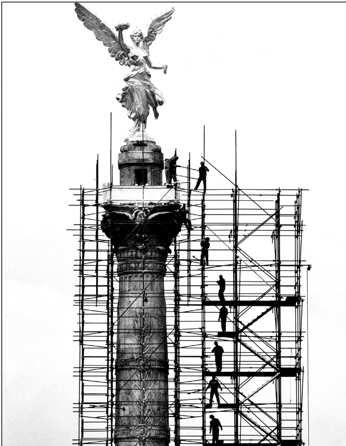
Empleados del Gobierno del Distrito Federal durante las arduas jornadas de remodelación de la Columna de la Independencia. La limpieza y renovación de la Victoria Alada tuvieron una inversión de 40 millones de pesos y se centraron principalmente en la estética; desde un dorado completo hasta la reposición de la cantera, los mármoles y los bronce. El monumento estará listo para el 13 de septiembre, día en que comienzan los festejos patrios ■ Marco Peláez
