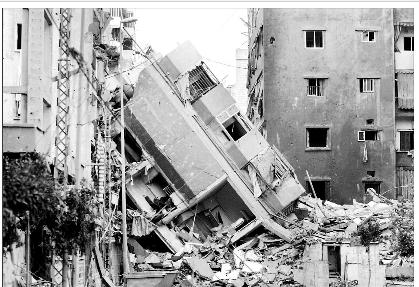
Destrucción de una zona habitacional en el sur de Beirut tras el bombardeo israelí. El Fondo de Naciones Unidas para la Infancia (Unicef) informó que la situación en Líbano es “catastrófica” y más de medio millón de habitantes fueron obligados a huir ■ Reuters
