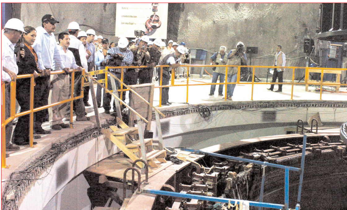
El presidente Vicente Fox supervisa las obras de la presa El Cajón ■ Notimex
