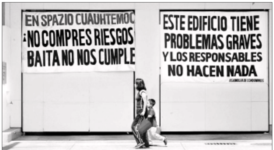
El edificio ubicado en avenida Cuauhtémoc 579, emblemático de las múltiples irregularidades de constructoras ■ María Luisa Severiano
