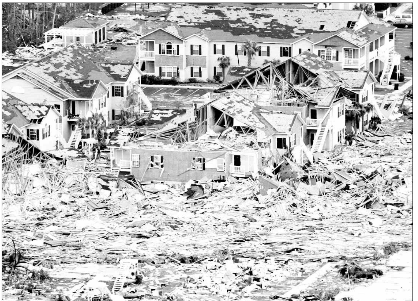
Destrucción causada por el huracán Katrina en un complejo habitacional en Long Beach, Mississippi
