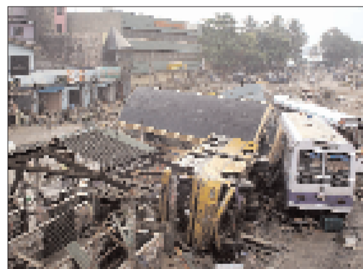
Imagen del 27 de diciembre que muestra la destrucción de la terminal de autobuses de Galle, a 125 kilómetros al sur de Colombo, capital de Sri Lanka
