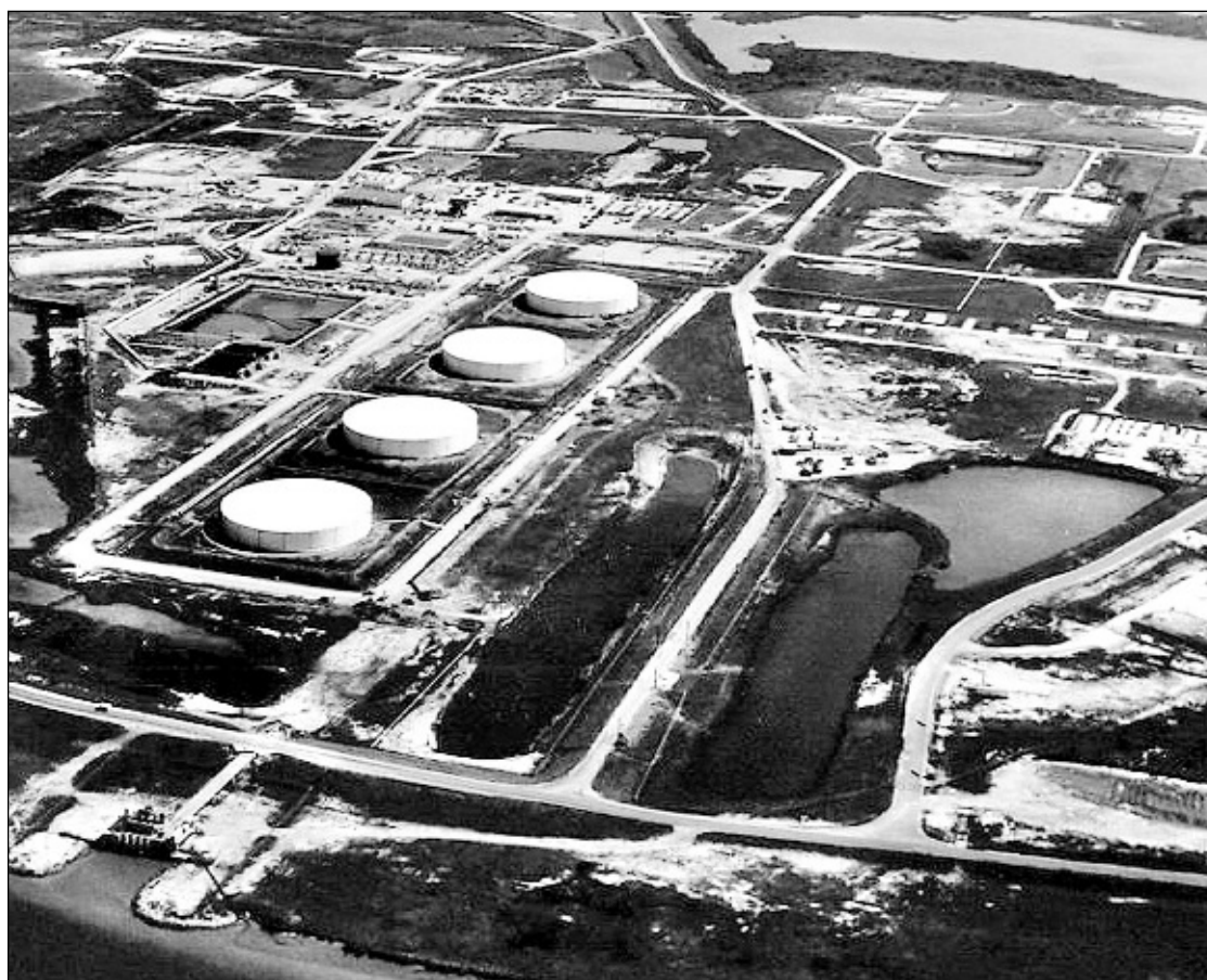
Imagen tomada del sitio de Internet del Departamento de Energía de Estados Unidos, que muestra uno de los conjuntos de depósitos de la reserva estratégica de petróleo de ese país, ubicada en el condado de Brazoria, Texas
